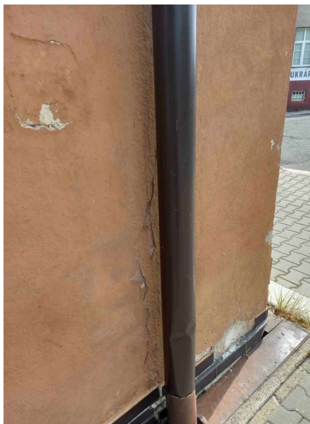
Poškození fasády kolem svodu
