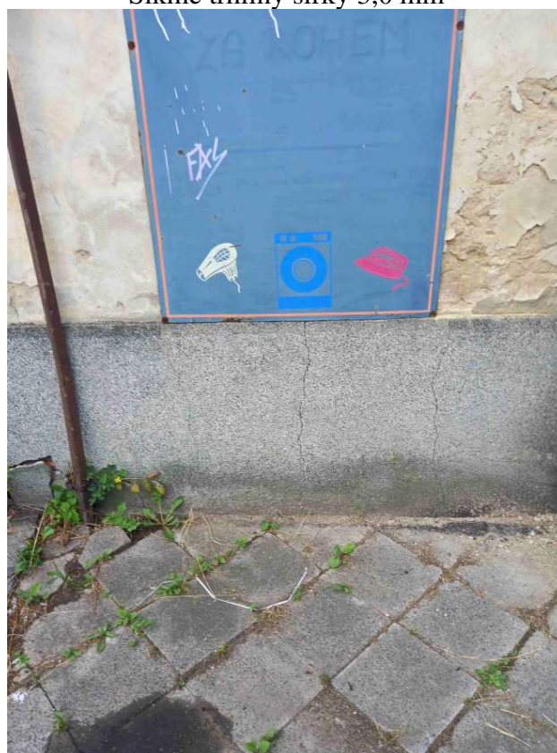
Svislé trhliny ve spodní části nad mostem
