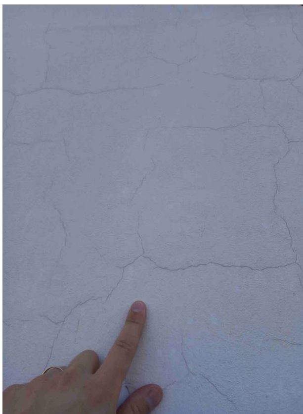
Všesměrné trhliny ve fasádě
