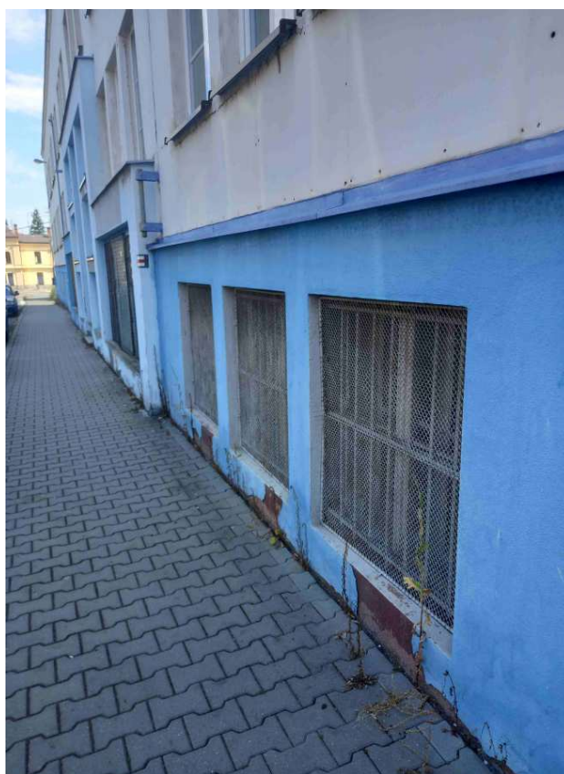
Poškození fasády pod okny
