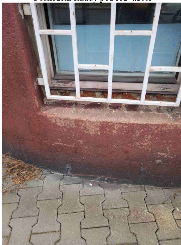
Trhliny pod okny na rohu budovy
