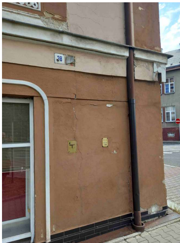
Trhliny šířky 0,6 mm na rohu domu z ulice Dolní Brána
