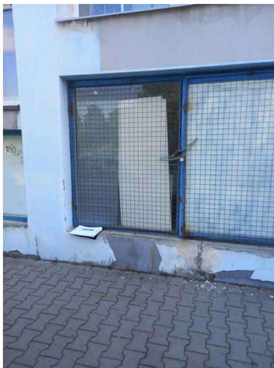
Poškození fasády kolem oken
