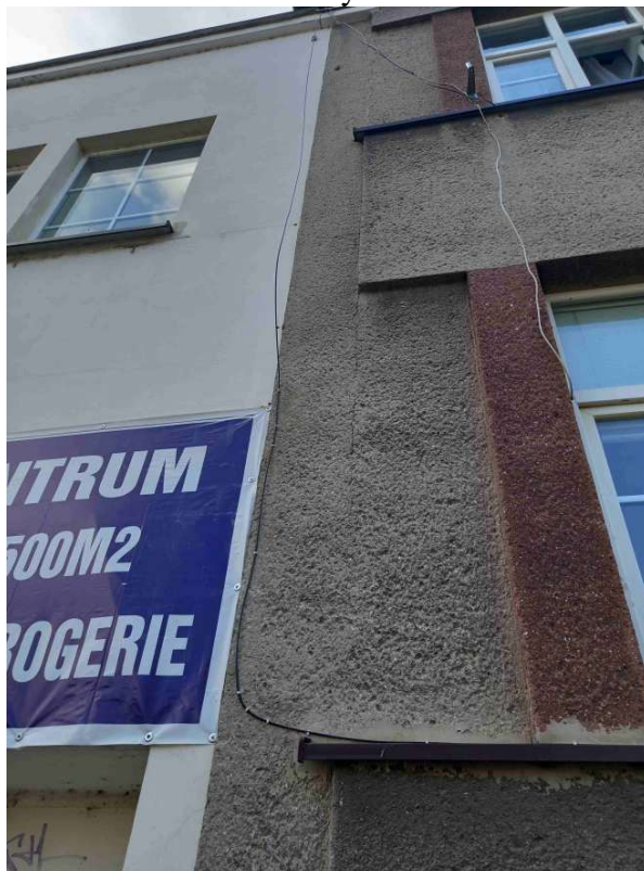
Svislá trhlina z ulice vedle sousední části domu
