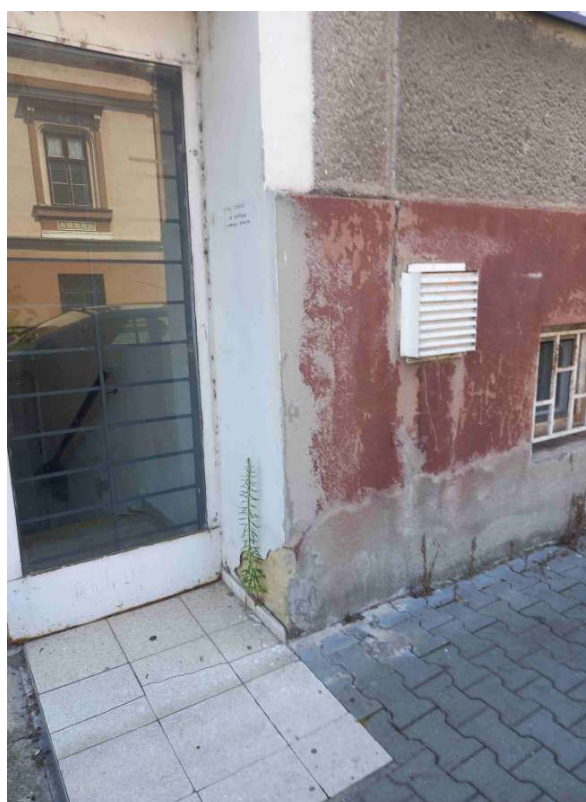
Poškození fasády u dveří
