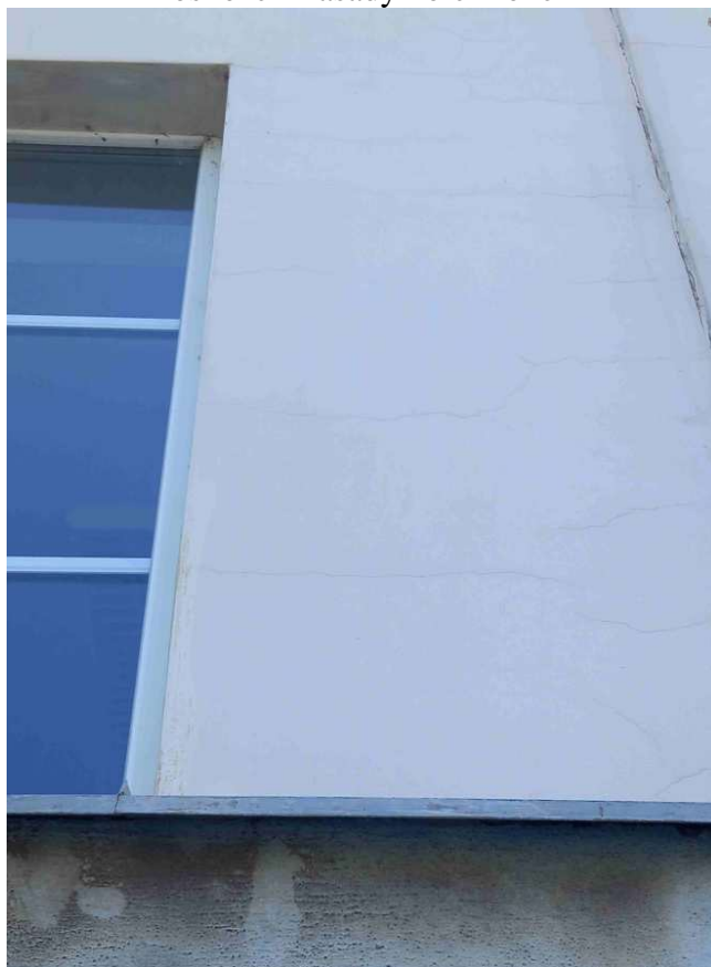
Všesměrné trhliny ve fasádě
