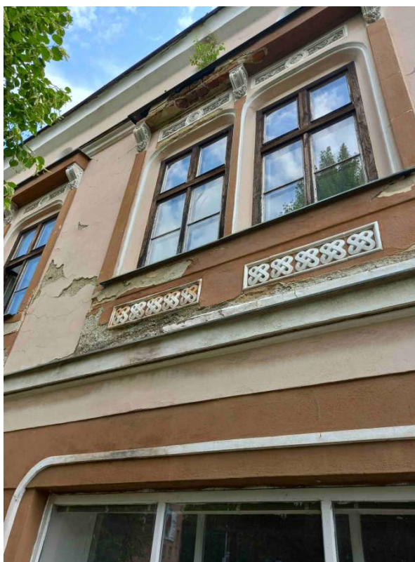
Poškození fasády v horní části budovy z ulice Dolní Brána
