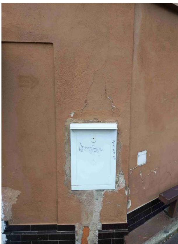
Poškození fasády kolem rozvaděče
