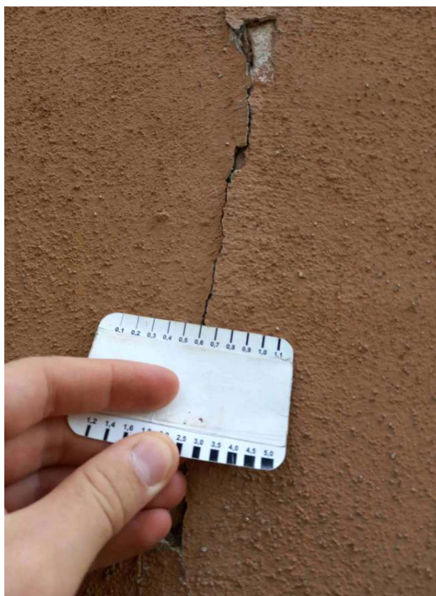
Šířka trhliny 0,6 mm
