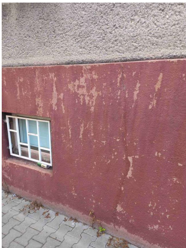
Mnohačetné svislé trhliny z ulice U Grasmanky
