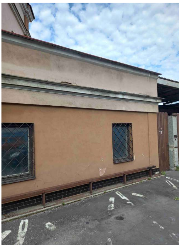
Poškození fasády nad atikou
