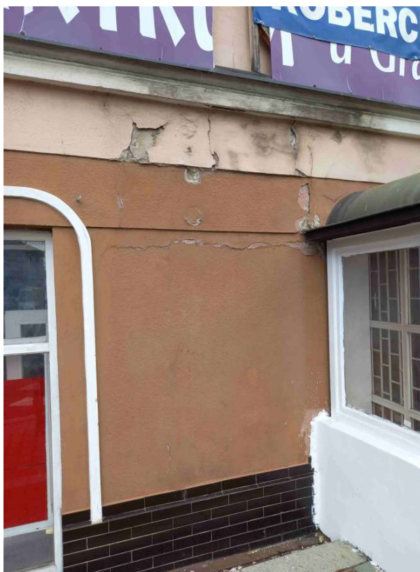
Trhliny kolem vstupních dveří šířky 0,6 mm
