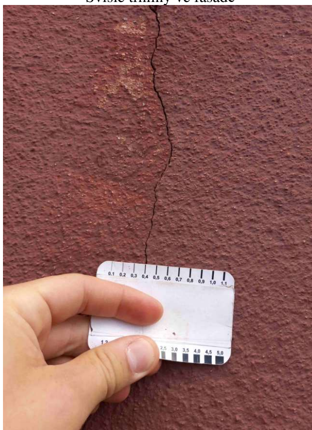
Šířka trhliny 0,4 mm
